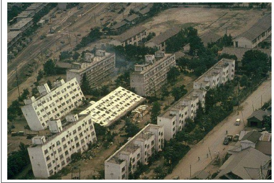
Fig. 2 – Effetti della liquefazione del terreno indotta dal terremoto del 1964 a Niigata (Giappone)
