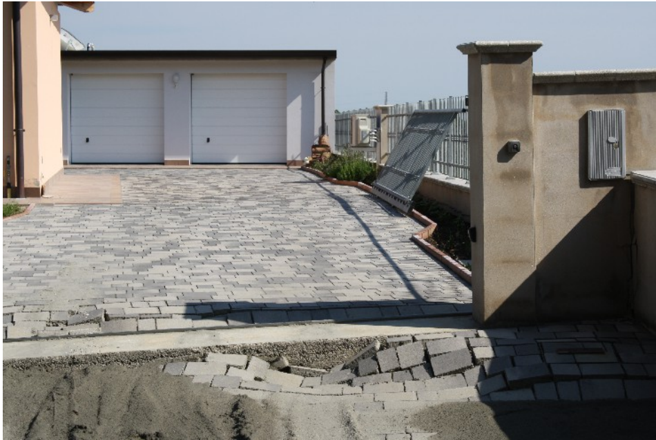
Fig. 8 – Abbassamento del suolo conseguente alla liquefazione in corrispondenza di un passo carraio a San Carlo (FE)
